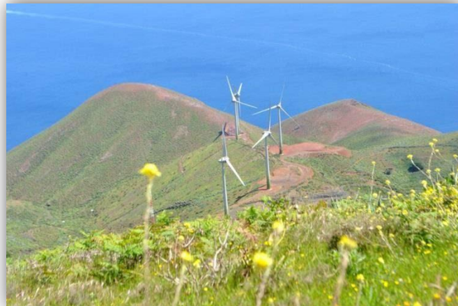
11,5 MW Wind farm
